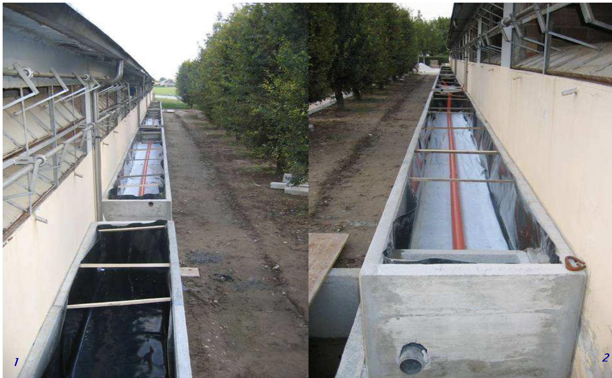
Esecuzione dei lavori flusso verticale
